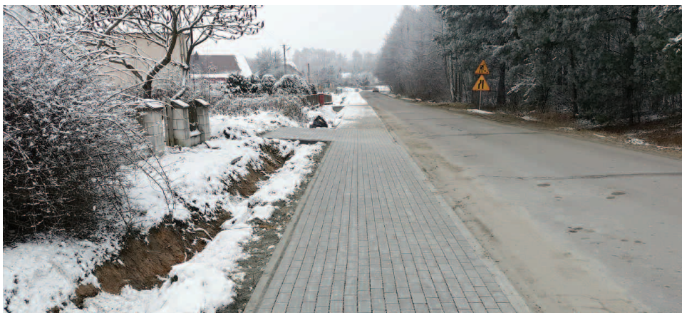
Chodnik przy drodze powiatowej
