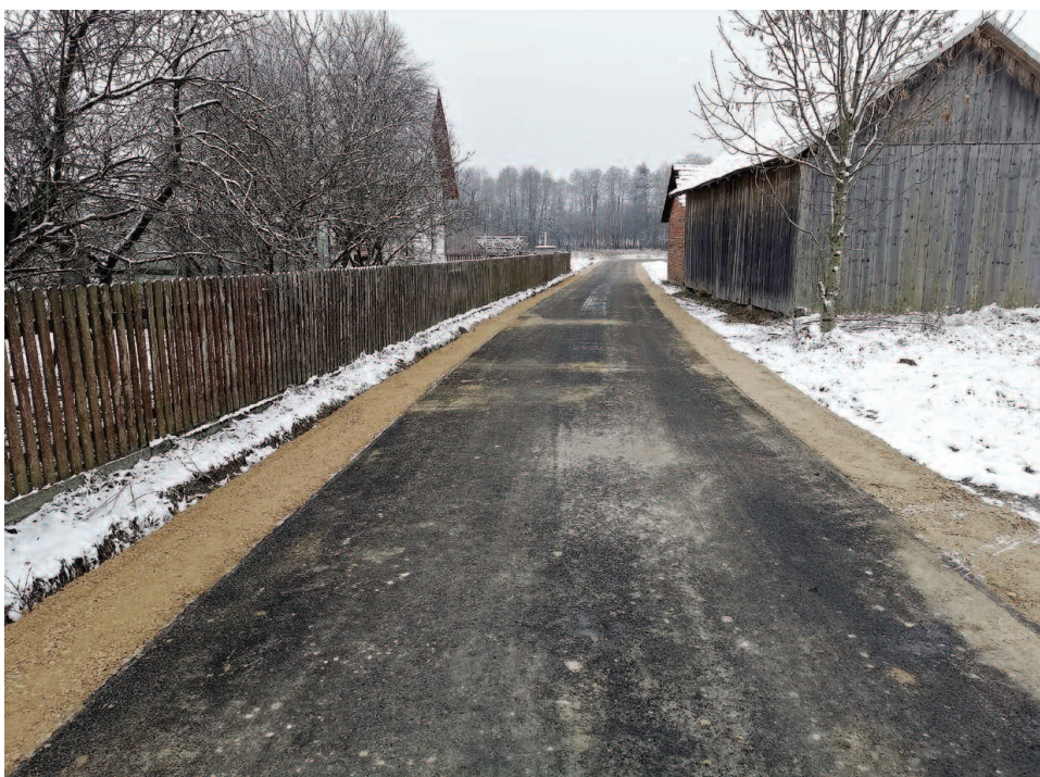
Przebudowa drogi wewnętrznej w msc. Wydrze
