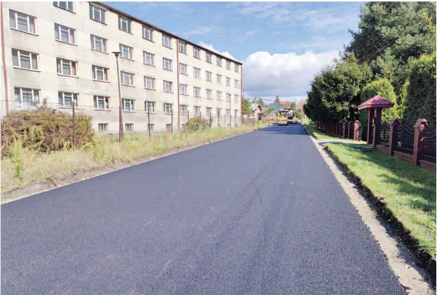
Przebudowa drogi gminnej Rakszawa ZSTG - Rakszawa Wołochy - w trakcie wykonywania robót.
