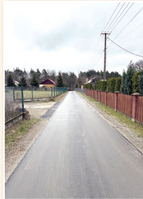
>>> Asfaltowanie drogi nr 1438/3 w sołectwie Rakszawa Górna
