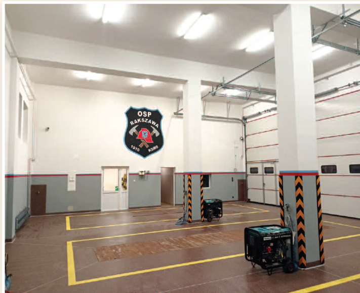
>>> Przebudowa garaży w OSP Rakszawa
