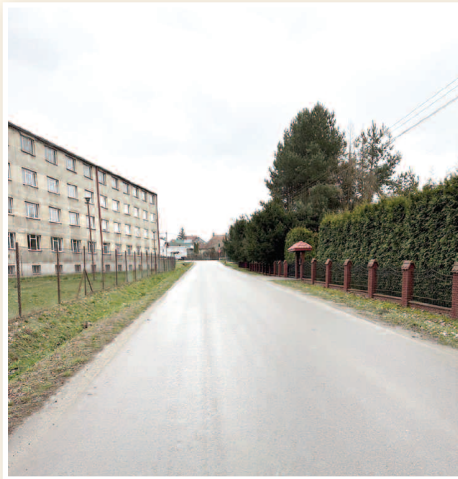
>>> Przebudowa drogi publicznej Rakszawa ZSTG- Rakszawa Wołochy
