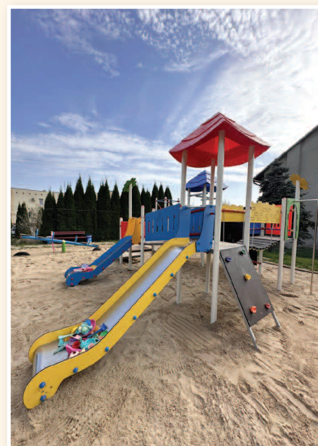
>>> Przebudowa placu zabaw przy Szkole Podstawowej nr 2 w Rakszawie
