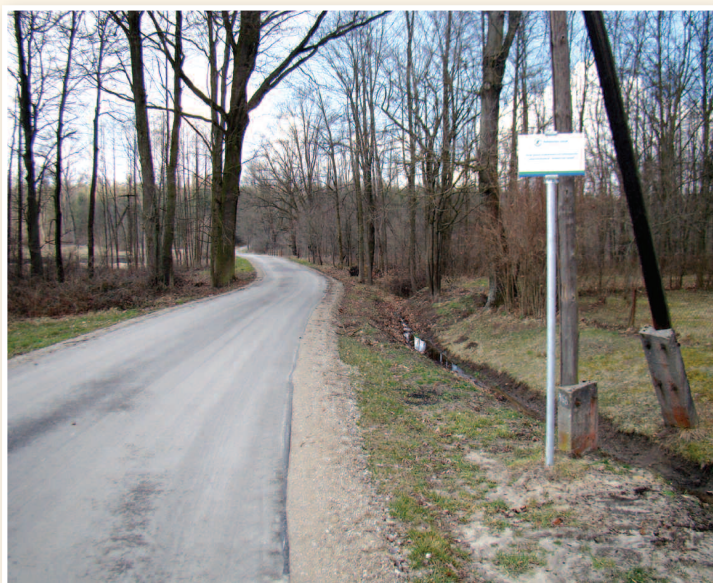
>>> Przebudowa drogi w Wydrzu do Leśniczówki
