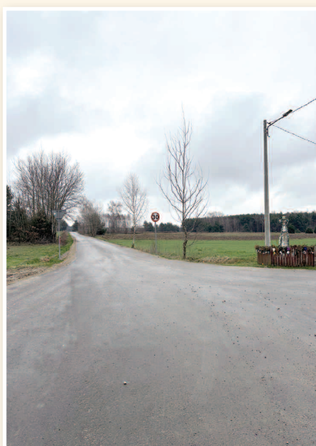
>>> Przebudowa drogi wewnętrznej - Wyrze Morgi
