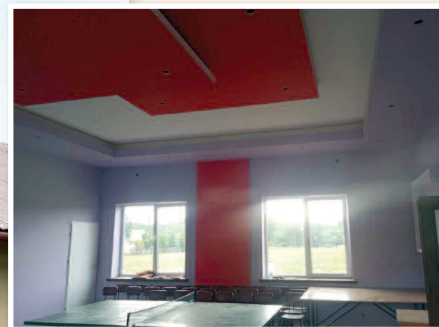
>>> Wymiana bramy w OSP Rakszawa Kąty wraz z remontem świetlicy, kuchni i łazienek
