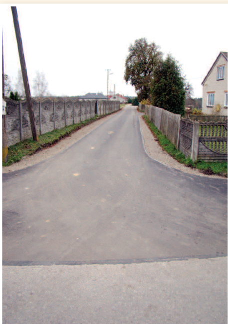
>>> Przebudowa drogi w Wydrzu [Biblioteka]
