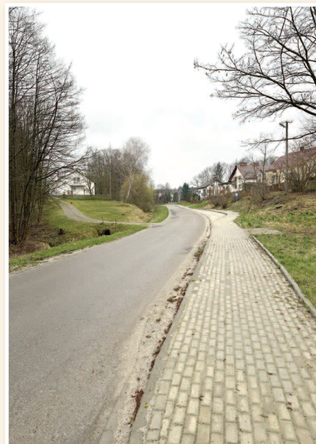
>>> Budowa chodnika przy drodze powiatowej Rakszawa - Bieleckówka
