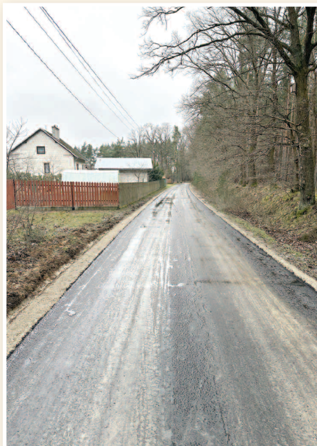
>>> Przebudowa drogi w przysiółku Basakówka k. stacji paliw [odcinek 2]
