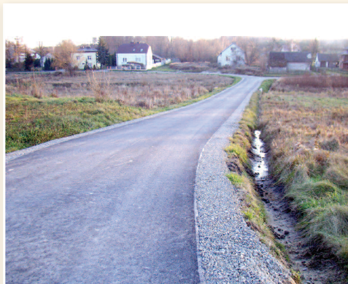
>>> Przebudowa drogi wewnętrznej w Węgliskach za remizą OSP
