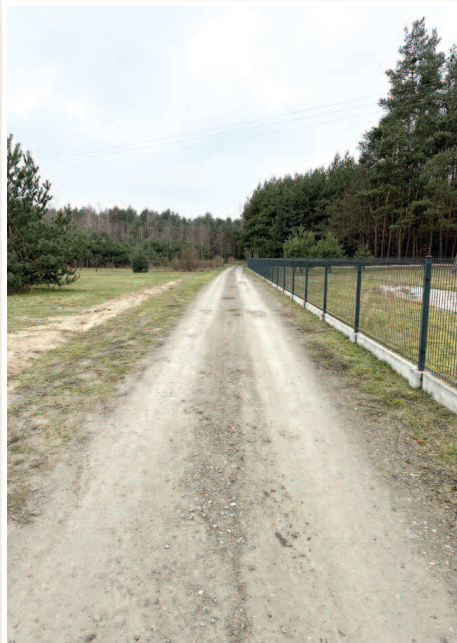
>>> Modernizacja dróg dojazdowych w przysiółku Dymarka: droga dojazdowa do gruntów rolnych w obrębie msc. Rakszawa, dz. o nr ewid. 7417
