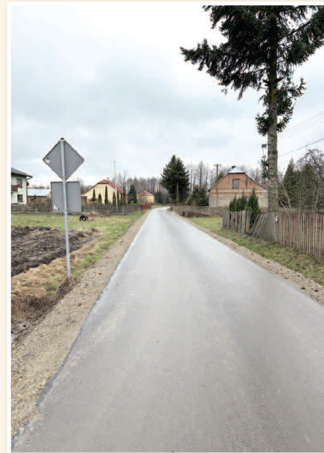
>>> Przebudowa drogi gminnej w Sołectwie Rakszawa Kąty - Cegielnia
