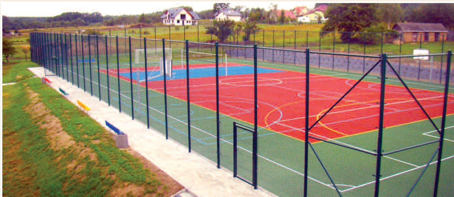
>>> Budowa boiska wielofunkcyjnego z wiatą w msc. Węgliska
