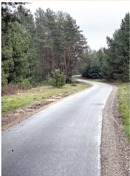
>>> Przebudowa drogi wewnętrznej w kierunku OSP Rakszawa - Kąty
