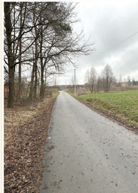
>>> Przebudowa drogi gminnej wewnętrznej o nr ewid. gr. 646 położonej w msc. Wydrze
