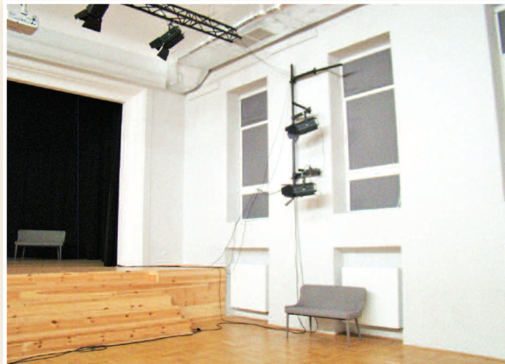
>>> Remont i wyposażenie sali teatralnej
