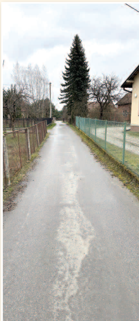
>>> Przebudowa drogi 7541/2 w przysiółku Rakszawa Dymarka
