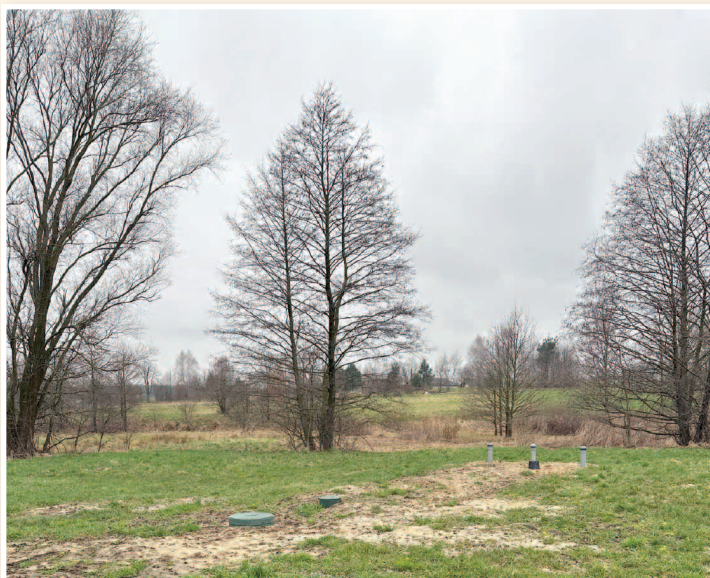
>>> Budowa sieci wodociągowych i sieci kanalizacyjnych oraz przydomowych oczyszczalni ścieków
