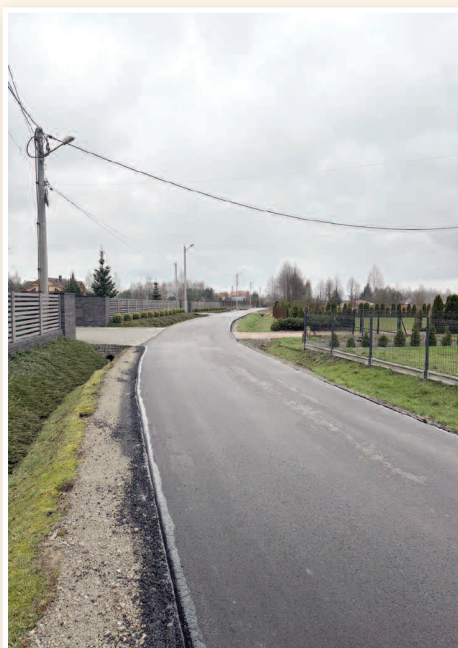
>>> Przebudowa drogi publicznej Rakszawa Basakówka - Dąbrówki Pastwiska
