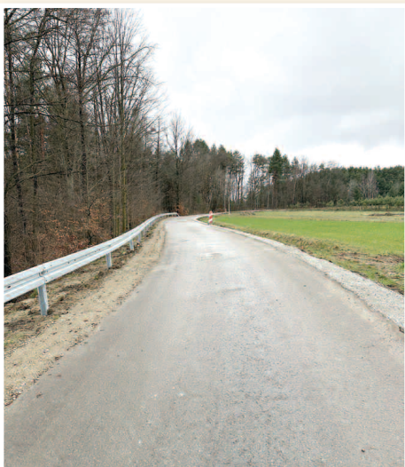
>>> Przebudowa drogi publicznej nr 109952R w Rakszawie
