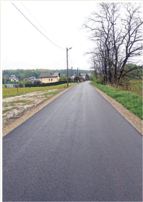
>>> Przebudowa drogi w Rakszawie tzw. Grobla
