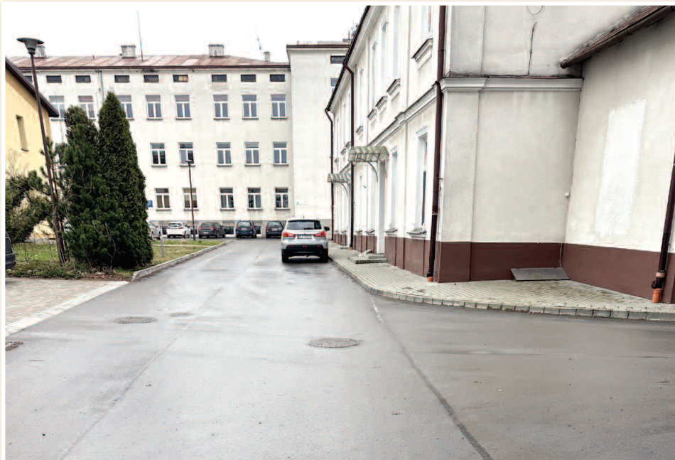
>>> Budowa sieci ciepłowniczej w Rakszawie [ZSTG]
