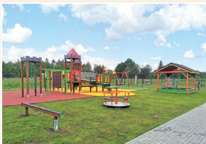
>>> Budowa placu zabaw w przysiółku Basakówka
