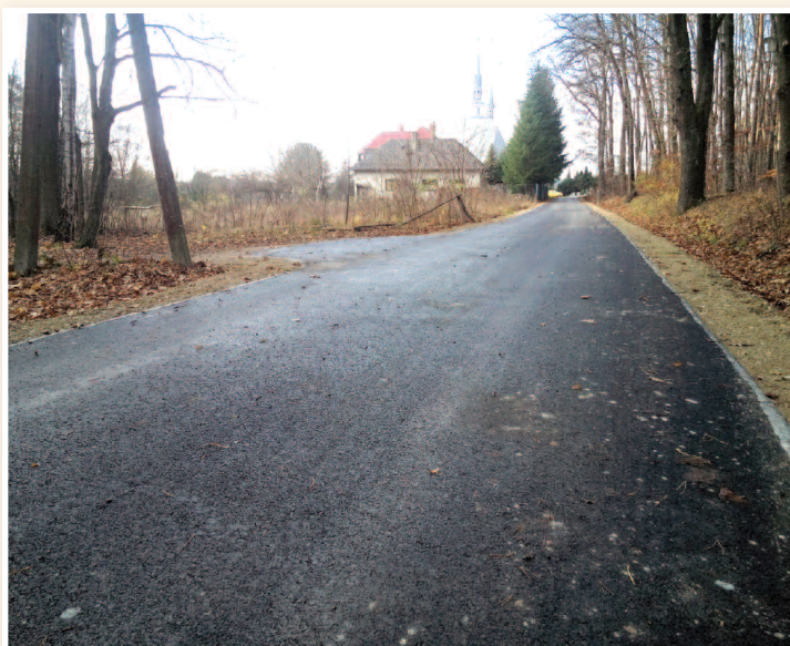
>>> Budowa drogi wewnętrznej w kierunku „Brzeźnika”
