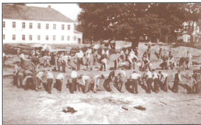
Uczniowie przy kopaniu fundamentów pod nowy budynek.
