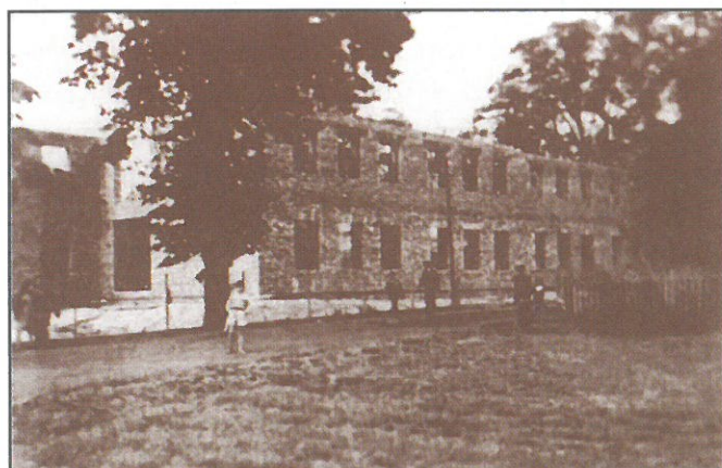
Nowy budynek szkoły w trakcie budowy.
